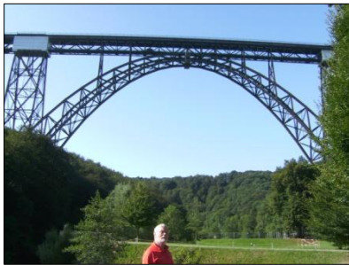
unter der Müngstener Brücke
